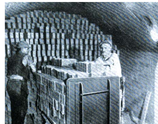
Ringofen zum Trocknen der Ziegelprodukte.
