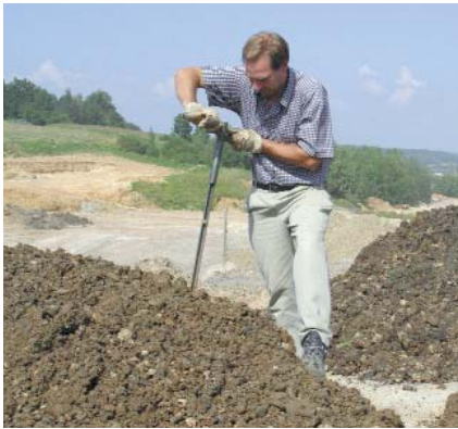
Gesetzliche Regelungen definieren, welche Materialien in der Friedrich-Zeche verfüllt werden dürfen.
