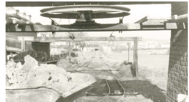
Ein Seilzug bringt die Loren zur Ziegelei. Jetzt erledigen Lastwagen den Transport.
