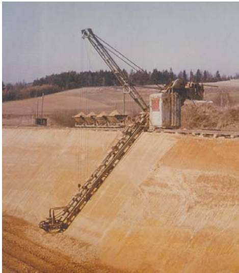
Mit einem Kettenbagger können die Rohstoffe in dünnen Schichten abgetragen werden.
