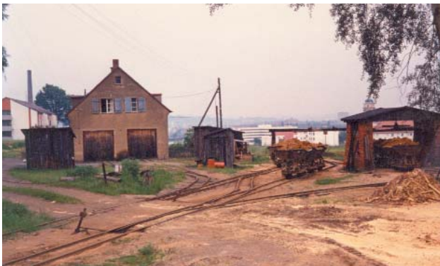
Die letzten 340 Meter zur Ziegelei wurden die Loren bis 1980 mit einem Drahtseilzug bewegt.
