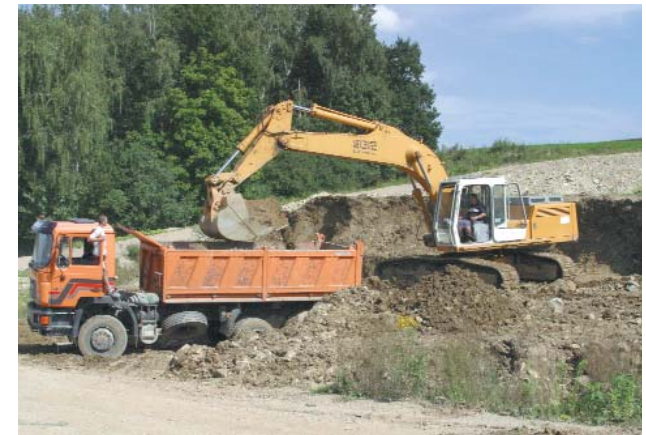
Mit einem modernen Maschinenpark werden heute die Rohstoffe abgebaut.
