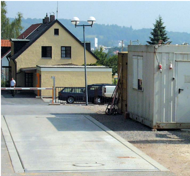
Die Fahrzeugwaage und das renovierte Bürogebäude.
