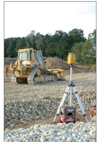
Die ehemalige Hausmülldeponie bei Hainsacker ist wieder dicht, die Gefahr der Umweltverschmutzung abgewendet.
