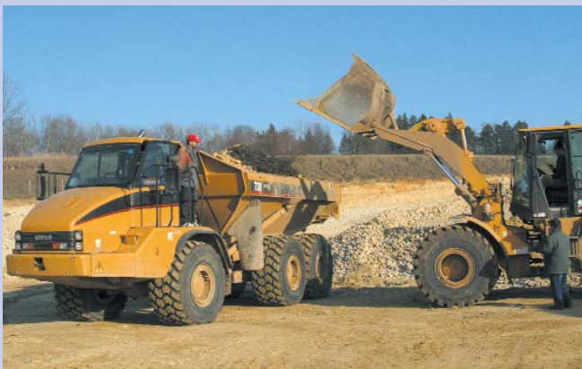
Neben dem Caterpillar ist ein zweiter Dumper bei Rösler im Einsatz.
