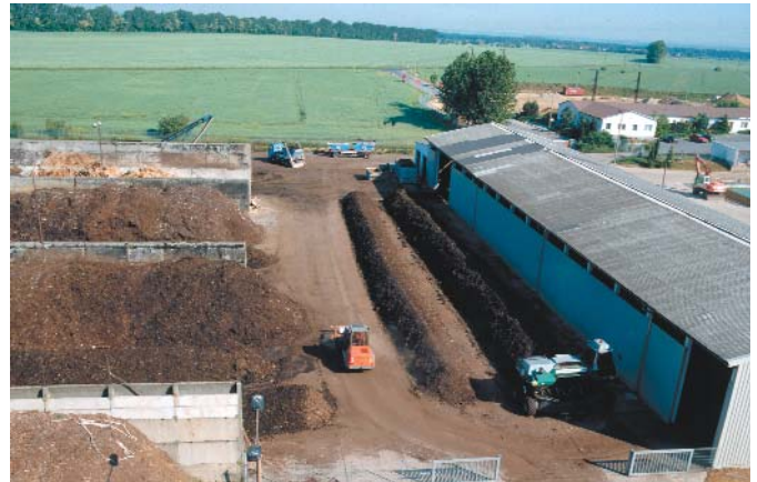
Das Werk in Liemehna beliefert die Riesen-Baustelle BMW-Werk Leipzig.
